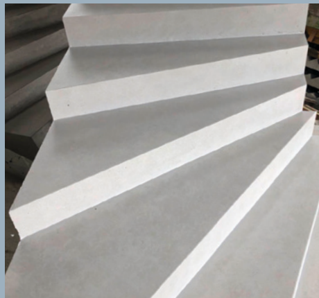
Gegossene Betontreppe – nachher
