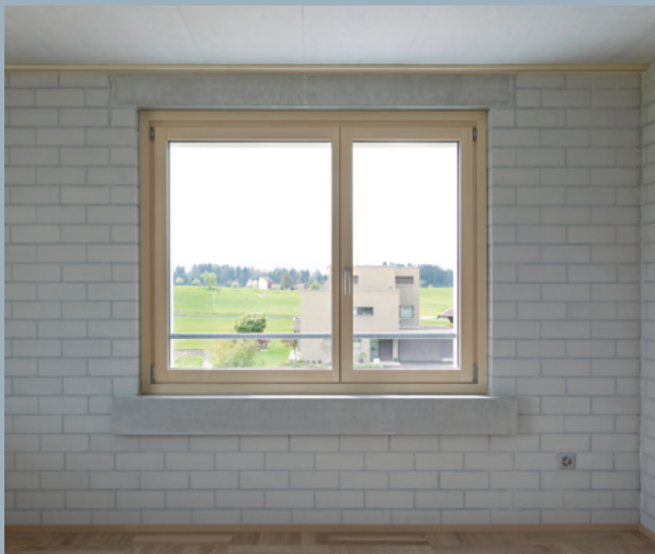
▲► Referenzbeispiel Neubau MFH Steinhausen: Schonende Reinigung mit Schwamm Brett, Scotchpad und Wasser. Kosmetik an Sichtbetonoberflächen und KS-Stein Mauerwerk sowie Sichtbetonlasur in einem feinen leicht gebrochenen Weiss Farbton (Architektur: TAONIUS GmbH; Fotos: Yoichi Iwamoto)
