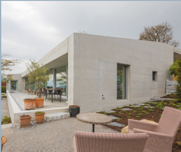
▲▶ Referenzbeispiel EFH: Sichtbetonreinigung im gesamten Aussenbereich sowie bei den Decken der Innenräume. Innenwände gestrichen.
