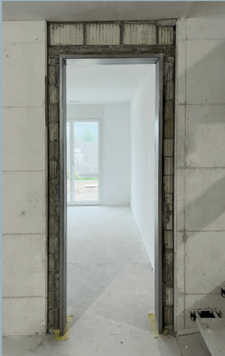
Anpassung Türrahmen – vorher
