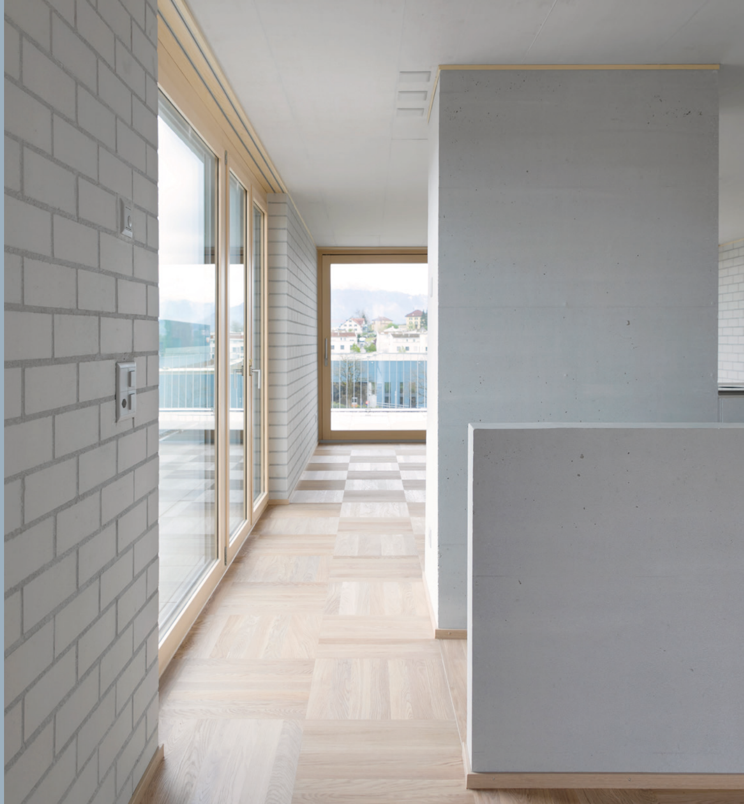
▲► Referenzbeispiel Neubau MFH Steinhausen: Schonende Reinigung mit Schwamm Brett, Scotchpad und Wasser. Kosmetik an Sichtbetonoberflächen und KS-Stein Mauerwerk sowie Sichtbetonlasur in einem feinen leicht gebrochenen Weiss Farbton (Architektur: TAONIUS GmbH; Fotos: Yoichi Iwamoto)
