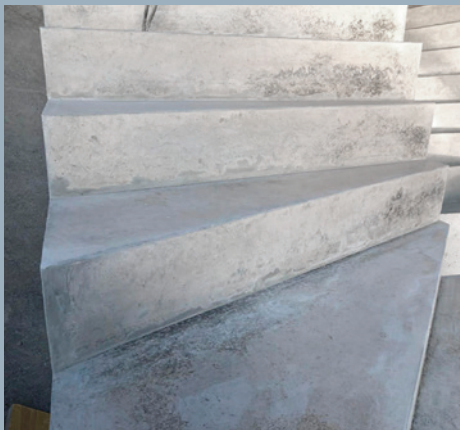
Gegossene Betontreppe – vorher
