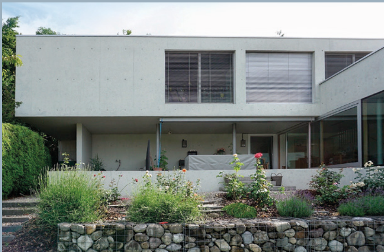
▲► Referenzbeispiel Renovation Sichtbetonfassade EFH Anglikon: Schonende Reinigung der Sichtbetonfassade mit Heisswasser-Hochdruckreiniger. Betonkosmetik, Tiefenhydrophobierung und Sichtbetonlasur in einem feinen warmen Grauton.
